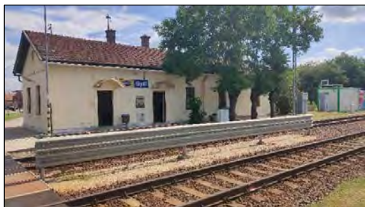
Gyál vasútállomás felvételi épülete
